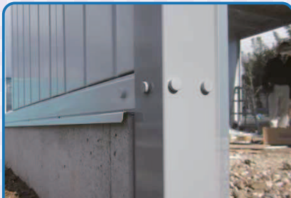
水切り板が外側に落ちるので、基礎の外寸法が重要です。
