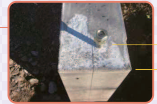
前柱は基礎の前に位置します。 (基礎の奥行寸法はその分本体より短くなります)
